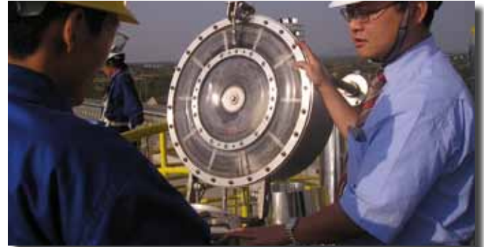
Bild 2: gute Zugänglichkeit für Wartungsarbeiten
